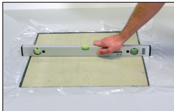
5. Lattialuukku säädetään oikeaan korkoon.
