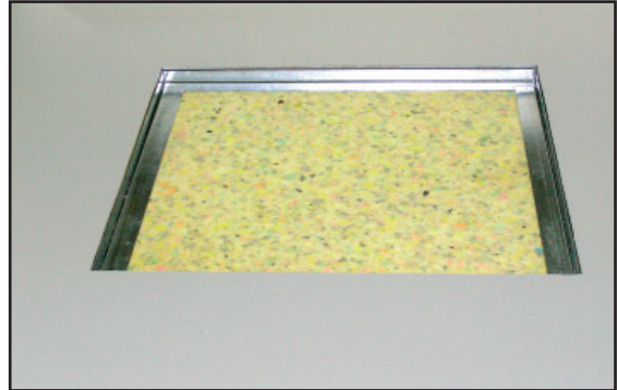
2. Laita lämmityslaitteen kansi ja äänieriste paikoilleen.
